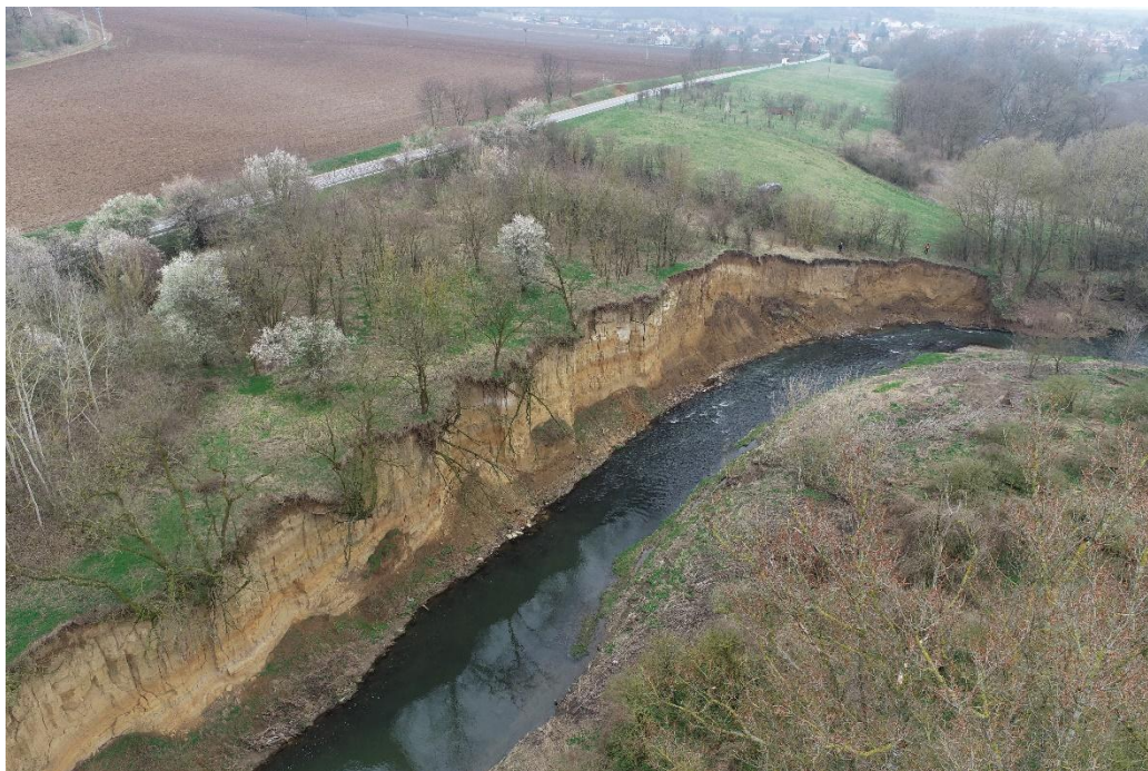
Obr. 1. Rozsáhlé řízení sprašových bloků do řečiště Olšavy. Sesuv 22685a.
